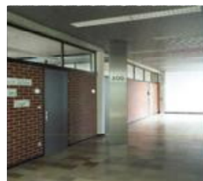
Schule um 1970 – innenliegende großzügige Erschließungsbereiche, natürlich belichtet
